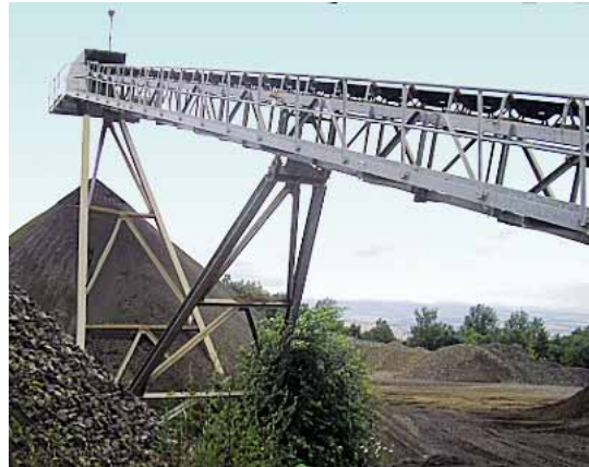
Haldenband in einem Basaltwerk
